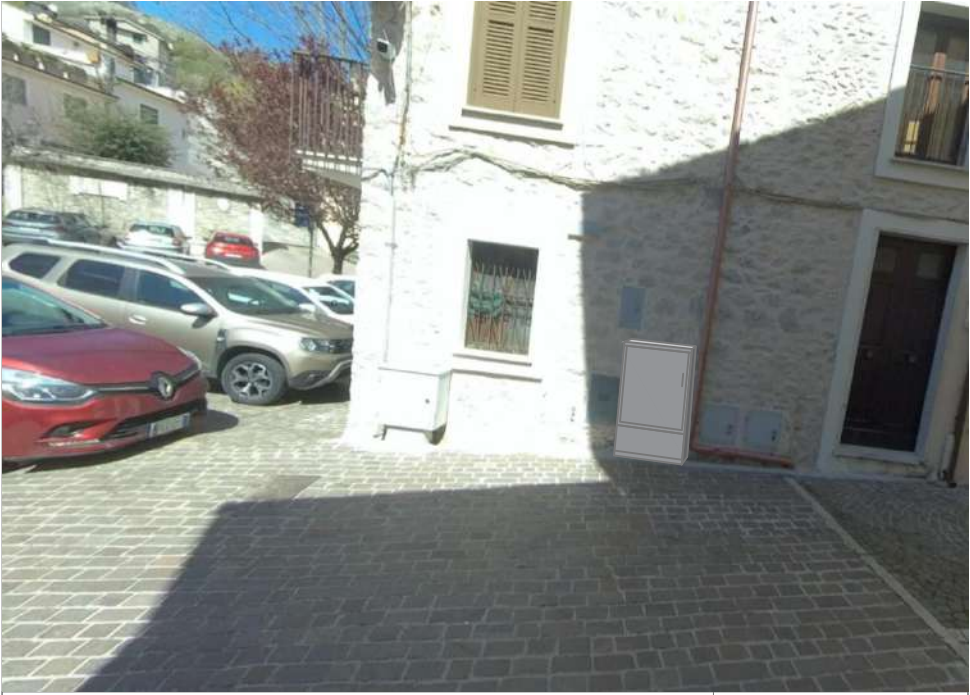
VIA MASTRO LAVINIO, in prossimità del Civico n.1
